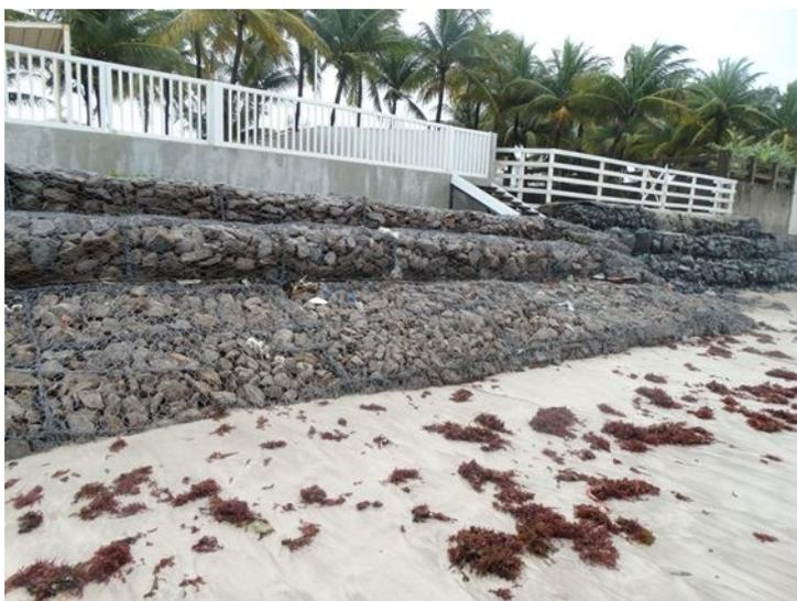
**Figura 1.** Obras de contenção à erosão costeira feitas por particulares. Este tipo de intervenção, sem um planejamento integrado, tende a causar efeitos colaterais nas áreas adjacentes, agravando o problema em escala municipal.
